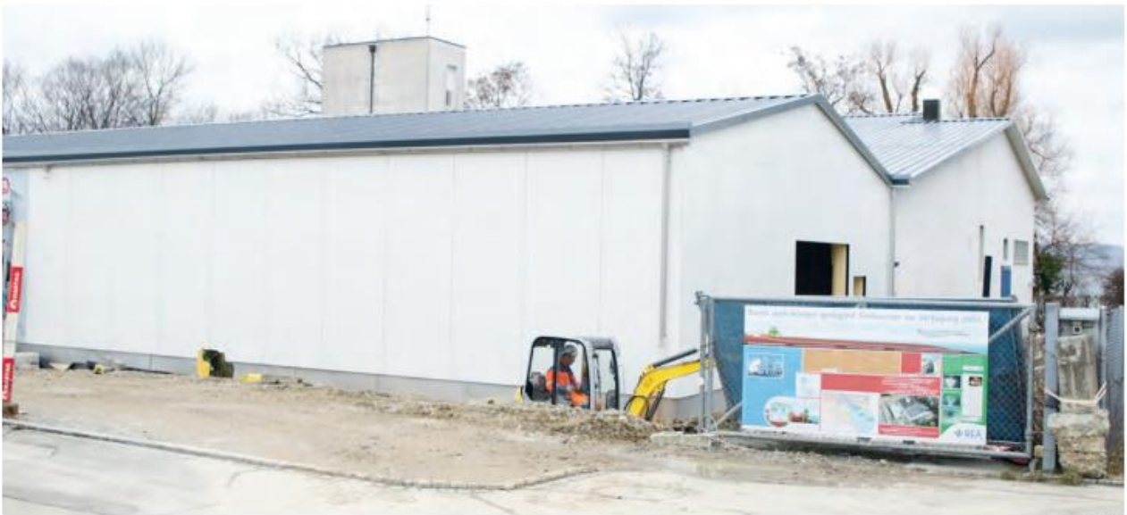
Im Vordergrund die neue Halle, in deren Untergeschoss die neuen Pumpen eingebaut werden. Hinten angebaut die ältere Halle des Werks. Bild: 145
